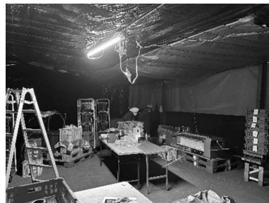
ポテライトを設置した出荷調整場の状況
