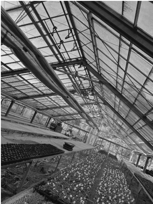
▲天窓側窓の開閉装置
