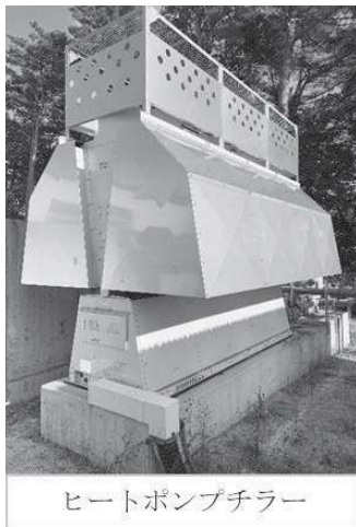
断熱仕様空調ハウスとHP空調機
