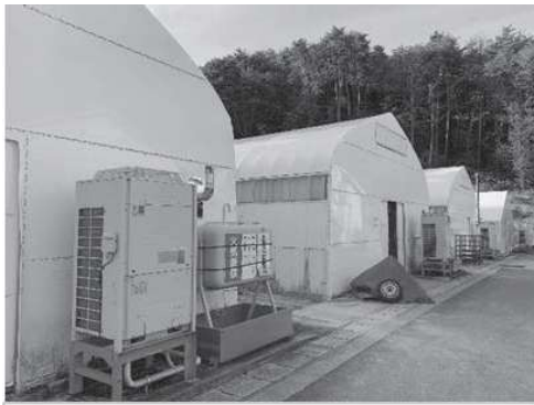
断熱仕様空調ハウスとHP空調機
